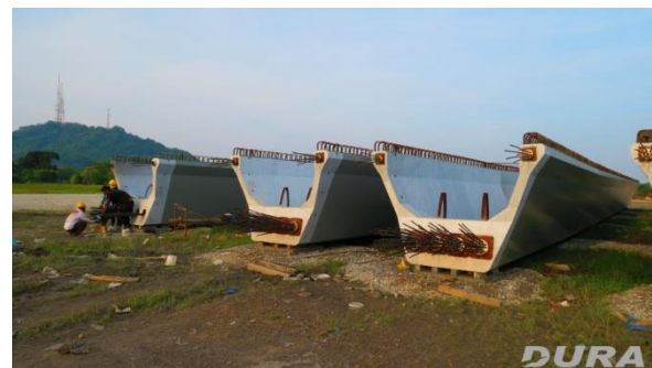
(d) Installation of strands and anchorage heads
