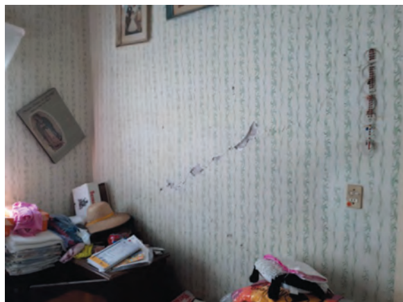
a) Daño medio en muro de carga
