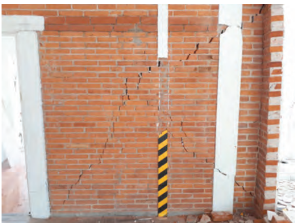
FIGURA 15. MUROS DE CARGA CON FALLA POR CORTANTE
