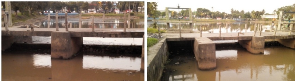
Gambar 13. Bangunan Pelimpah dan Pintu Air pada Kolam Retensi Sumber: dokumentasi penulis
